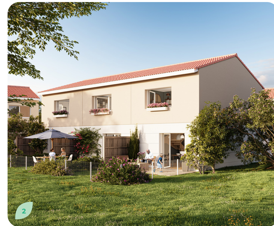
Vue d'une partie des maisons
