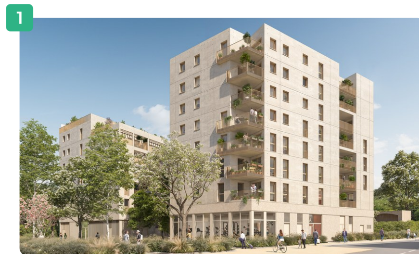
Vue du bâtiment A
