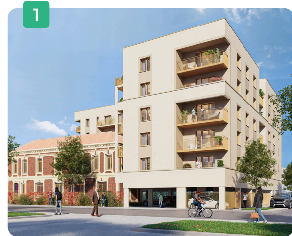
Vue côté entrée du parking
