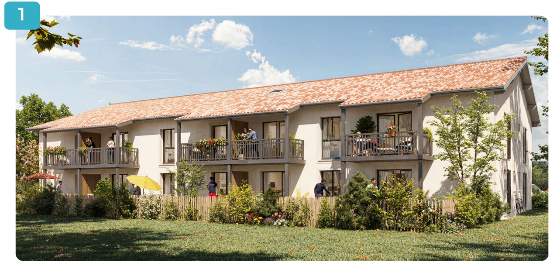
Vue du bâtiment A
